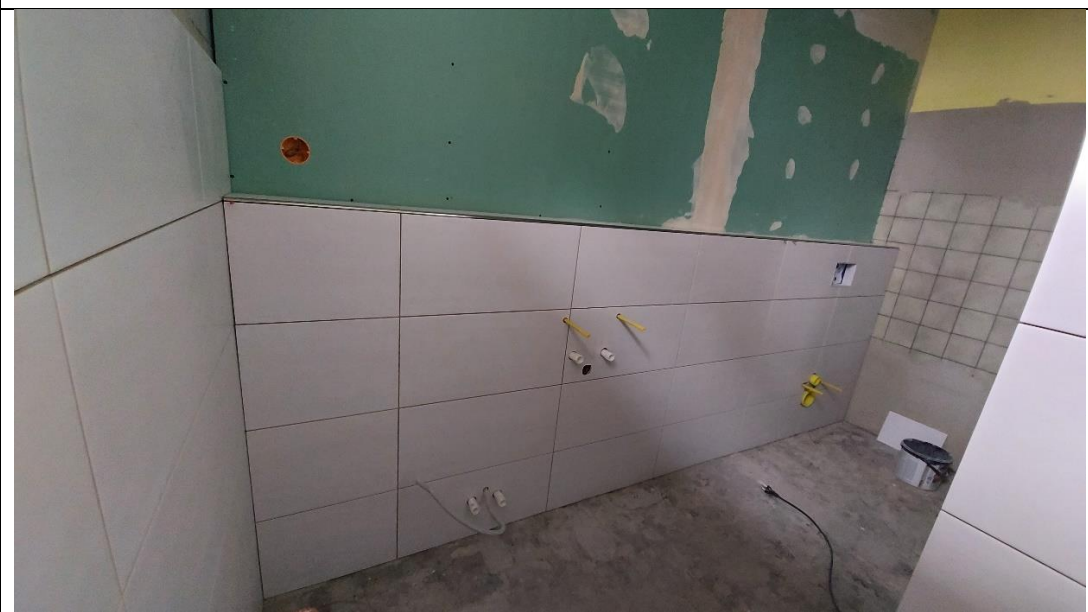
Eindrücke von der Renovierung der ALTEN SCHULE BÜTLINGEN
